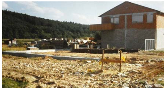
Neubau in Wächtersbach, Sommer 1986
