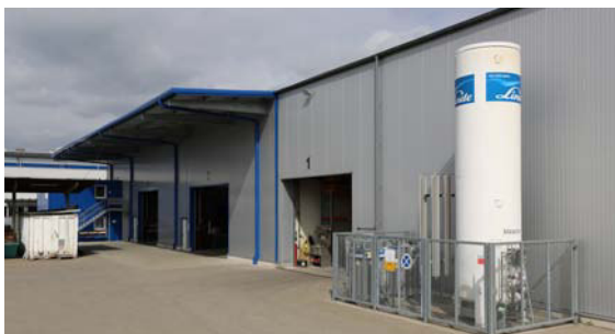
Neubau Halle 3, Sommer 2019
